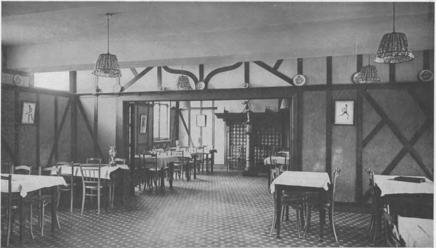
LA RASANTE T. C., à Woluwé. Pavement en carreaux céramiques 10 X 10 rouges avec bouchons à fleurons blanc et noir.
