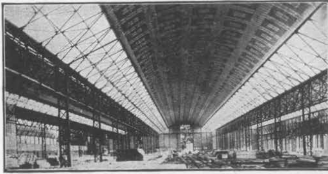
EXPOSITION D'ANVERS. SECTION BELGE. Vue intérieure des halls. Charpentes OMEGA.
