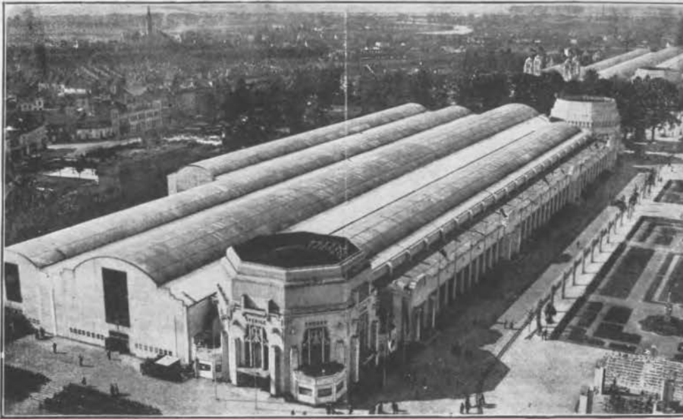
EXPOSITION D'ANVERS. SECTION BELGE. Vue d'ensemble des halls. Charpentes OMEGA.
