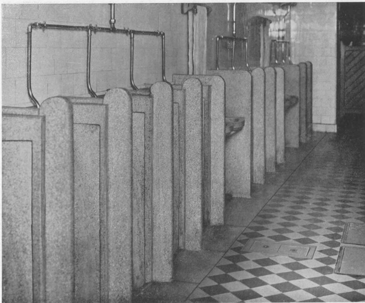
GRAND'POSTE DE BRUXELLES. Stalles d'urinoirs et lavabos en granito poli, revêtement blanc, pavement en grès-céram blanc et gris. Exécution : Et. H. BAUDOUX.
