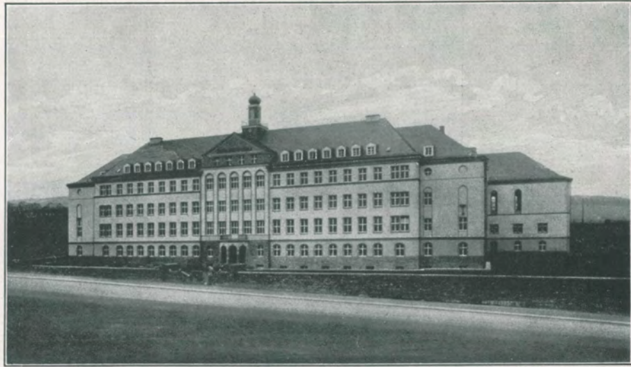
Enduits Montenovo (10,000 m 2 ). Vue du Lycée supérieur. OLPE (Westphalie).
