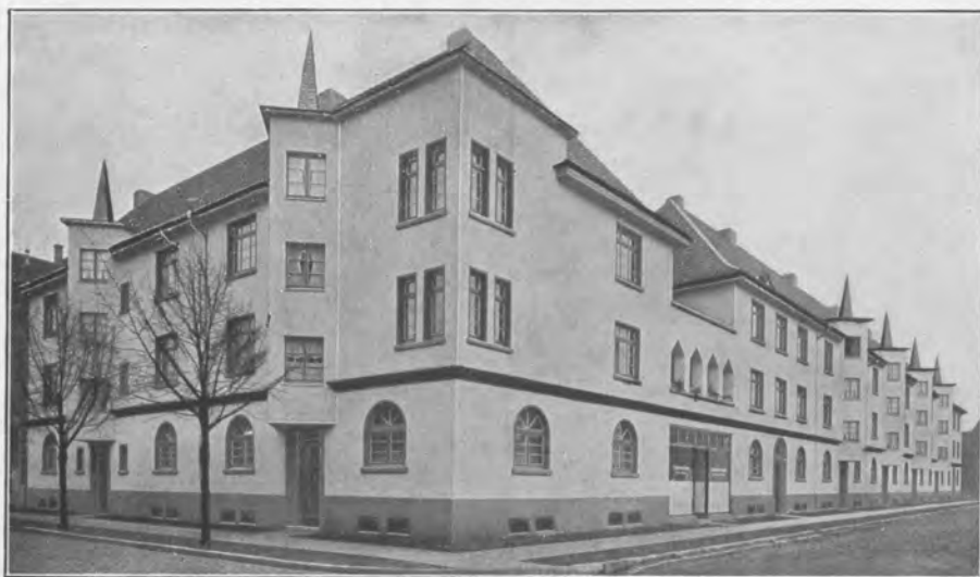
HAMM. Groupe d'habitations. Enduits Montenovo.
