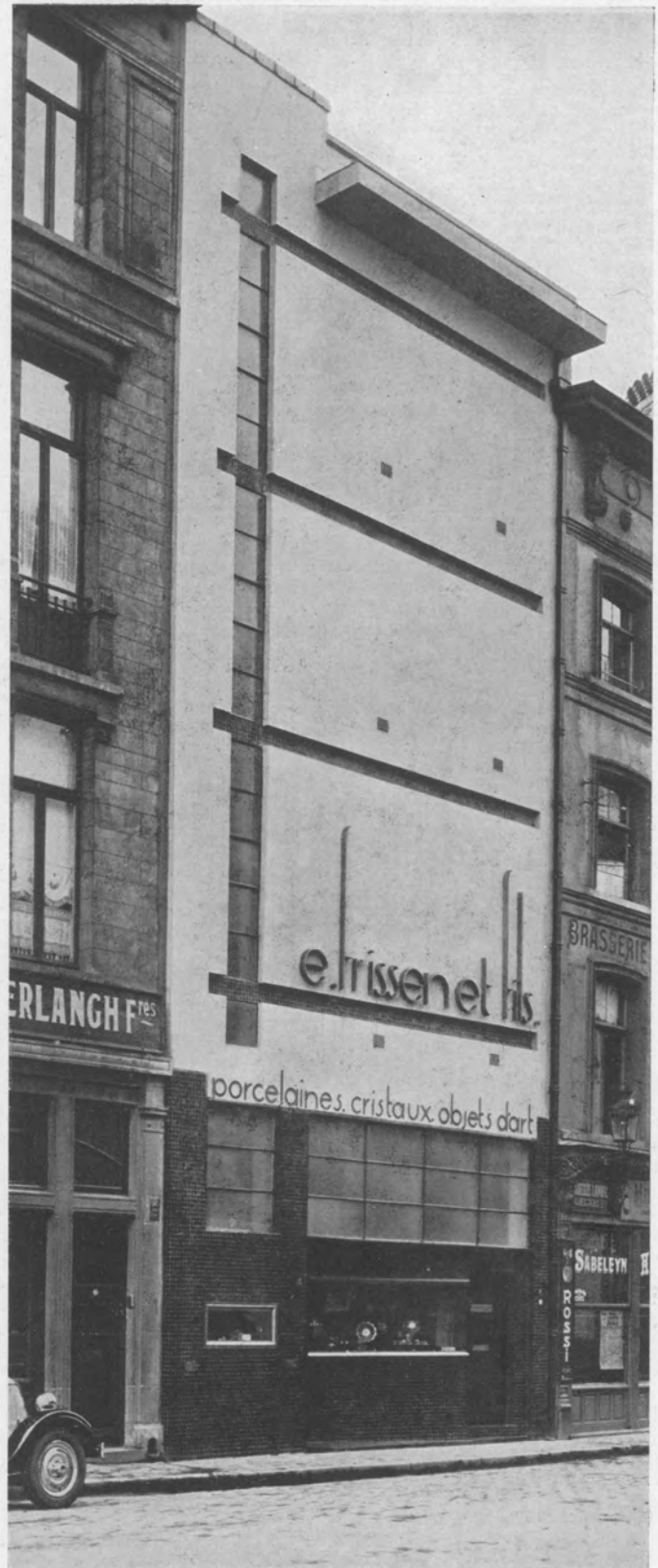
MAISON E. FRISSEN ET FILS, RUE D'ANDERLECHT. Ensemble de la façade, dont soubasse- ment et bandes en graniverre. Architecte : M. A. Barrez.
