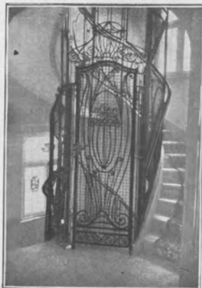
Ascenseur JASPAR installé dans un immeuble de rapport
