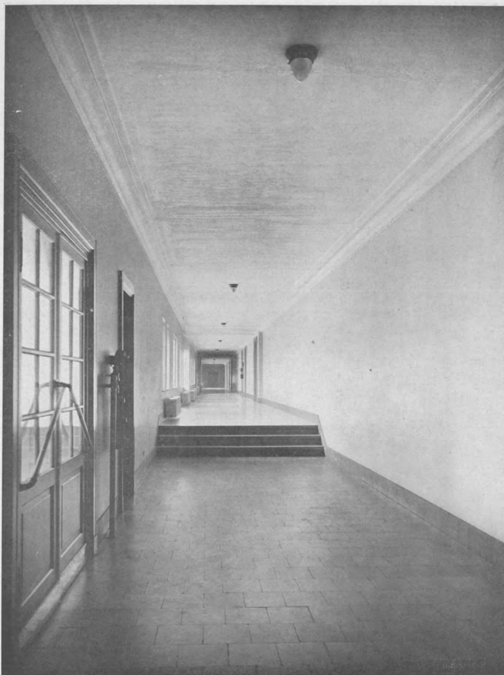
Palais de Justice de Louvain. Architecte : Mon- sieur Francotte. Un dégagement. Pavement en car- reaux Agma 25 × 25 jaunes. Plinthe Agma. Marches en granito. Exécution : Et. H. Baudoux. Photo : Sergysels.
