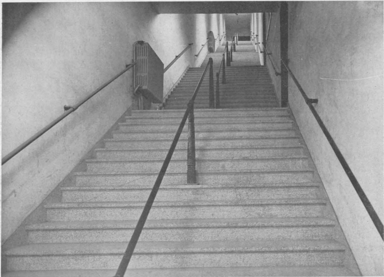
Cinéma « Roxy », à Bruxelles. Architecte : M. G. Quertainmont. Escalier de secours. Marches et limons de murs en granito. Exécution : Et. H. Baudoux. Photo : W. Kessels.
