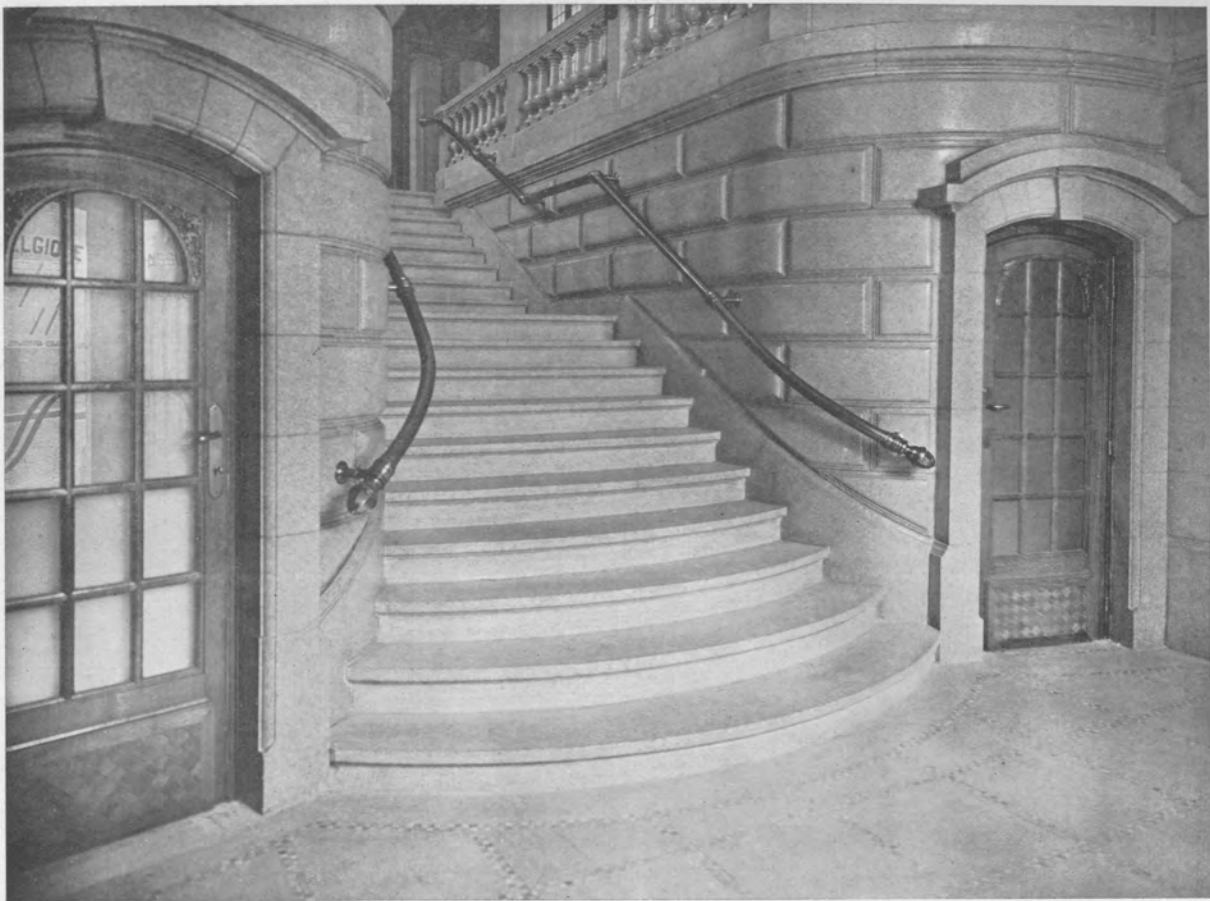
Société d'Assurances « La Belgique », rue Ernest Allard. Architecte : Monsieur F. Devestel. Entrée : revêtements et balustrades en granito poli Comblanchien. Marches et pavement même granito adouci. Exécution : Et. H. Baudoux. Photo : W. Kessels.
