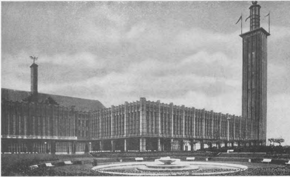
COLOGNE. Bâtiment des Expositions (partie nord).
