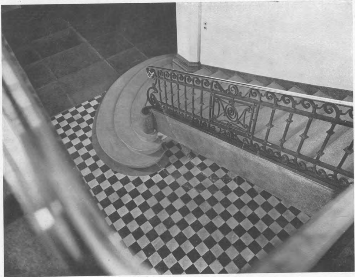
Société d'Assurances " La Belgique " Architecte : M. F. Devestel. Escalier et limon en granito comblanchien. Exécution : Et. H. Baudoux. Photo : W. Kessels.
