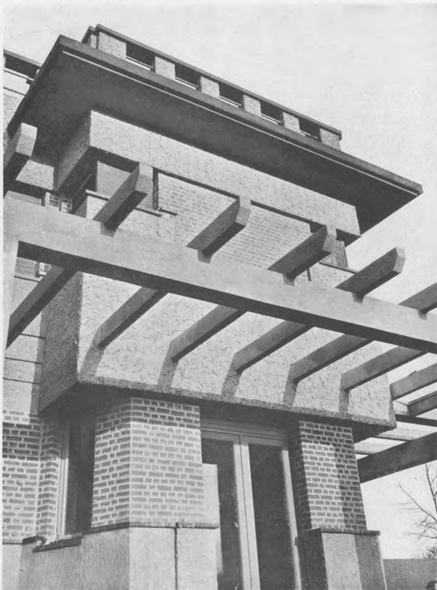
Villa à Groenendael (en construction). Architecte: M. Coppieters. Différentes applications des enduits G. G. en haut en- duit rond à la truelle. Per- gola en enduit au balais et enduit frotté. Plinthe en enduit "Messel". Photo : Willy Kessels.
