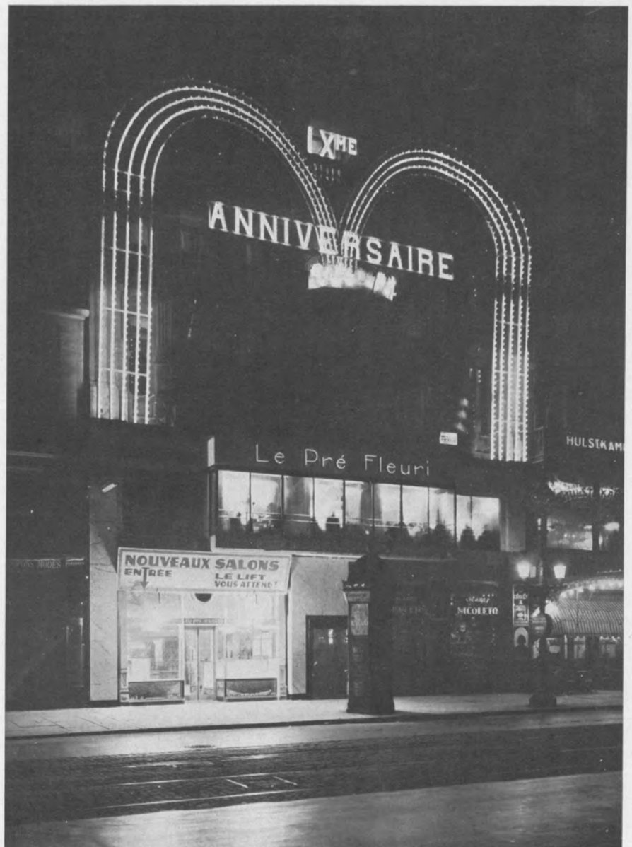
Le Pré Fleuri. Architecte : M. Georges Servais. Vue de nuit de la façade le jour de l'ouverture. Marbres : Merbes-Sprimont. Enseigne au Néon : C o Générale de Signalisations Lumineuses. Photo : W. Kessels.
