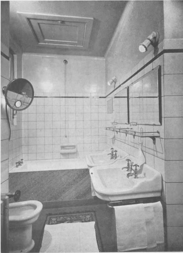
Hôtel Atlanta à Bruxelles. Architecte : M. Michel Polak. Collaborat. : M. Hoche. Une salle de bain. Revêtement en carreaux 15 x 15 blancs posés avec petits joints. Exécution : Et. H. Baudoux. Photo : W. Kessels.
