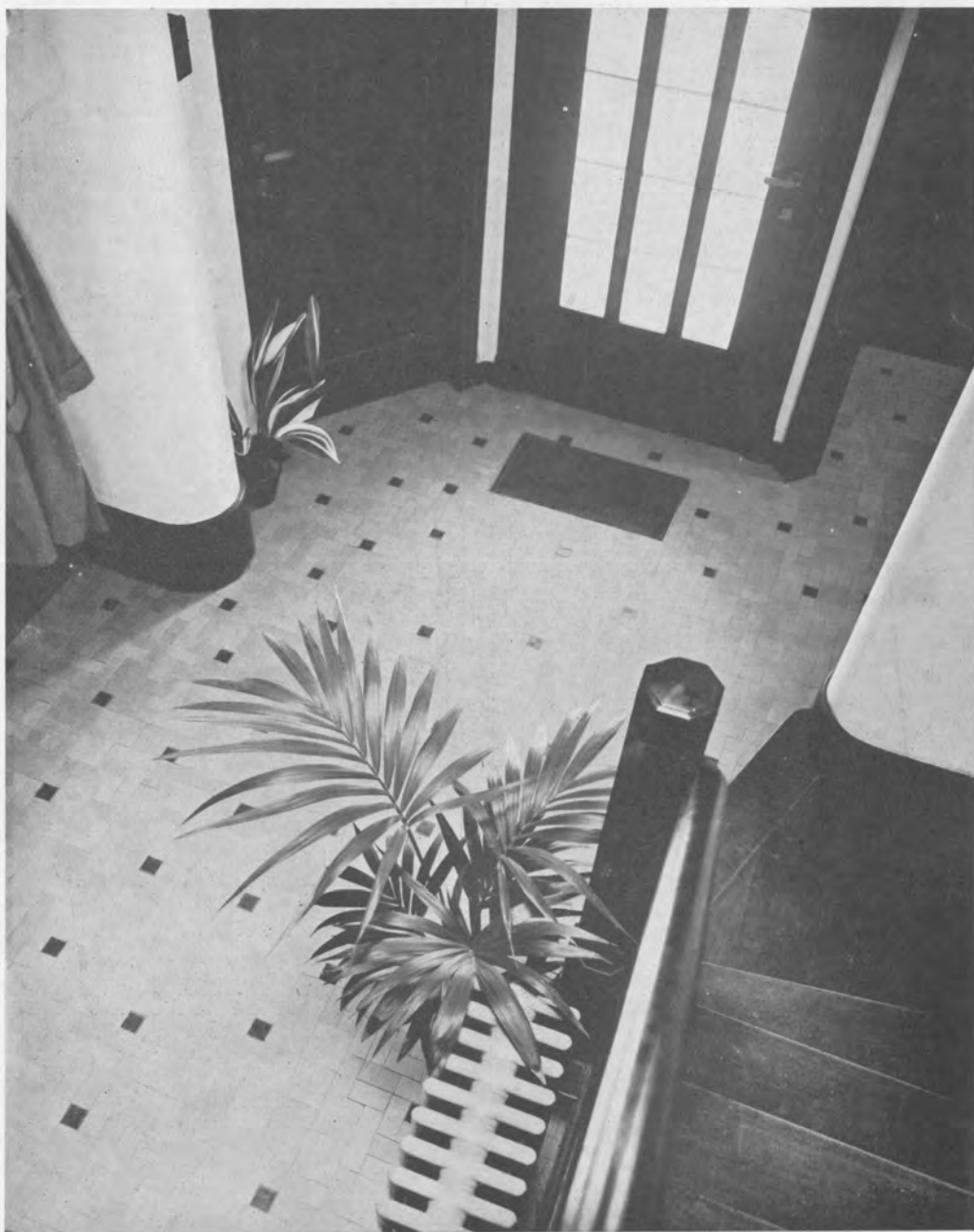
Immeuble Av. Ed. Mesens. Architecte : M. M. Haeck. Hall d'entrée. Pavem. en car- reaux cérami- ques bleus de trois tons légè- rement diffé- rents et de trois dimensions, re- levés de carre- lets 5 X 5 gra- niverres bruns violacés. Exécution : Et. H. Baudoux. Photo : W. Kessels.
