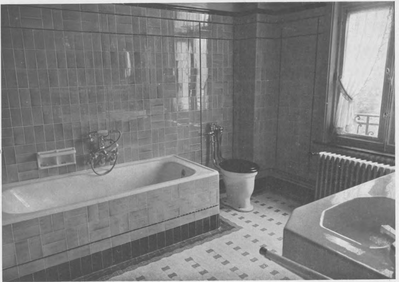
Salle de bain. Architecte : M. Devillers. Revêtement en carreaux majoliques 15 x 7,5 jaunes flammés, panneaux formés par des baguettes bosselées noires, plinthe et cimaise de même ton. Pavement en éléments curvilignes céramiques crèmes avec jeu de fond régulier en mosaïque de graniverre jaune d'or, bordure en mosaïque de graniverre jaune et curvilignes noirs, appareils blancs. Exécution (pavement et revêtement): Et. Baudoux. Photo : W. Kessels.
