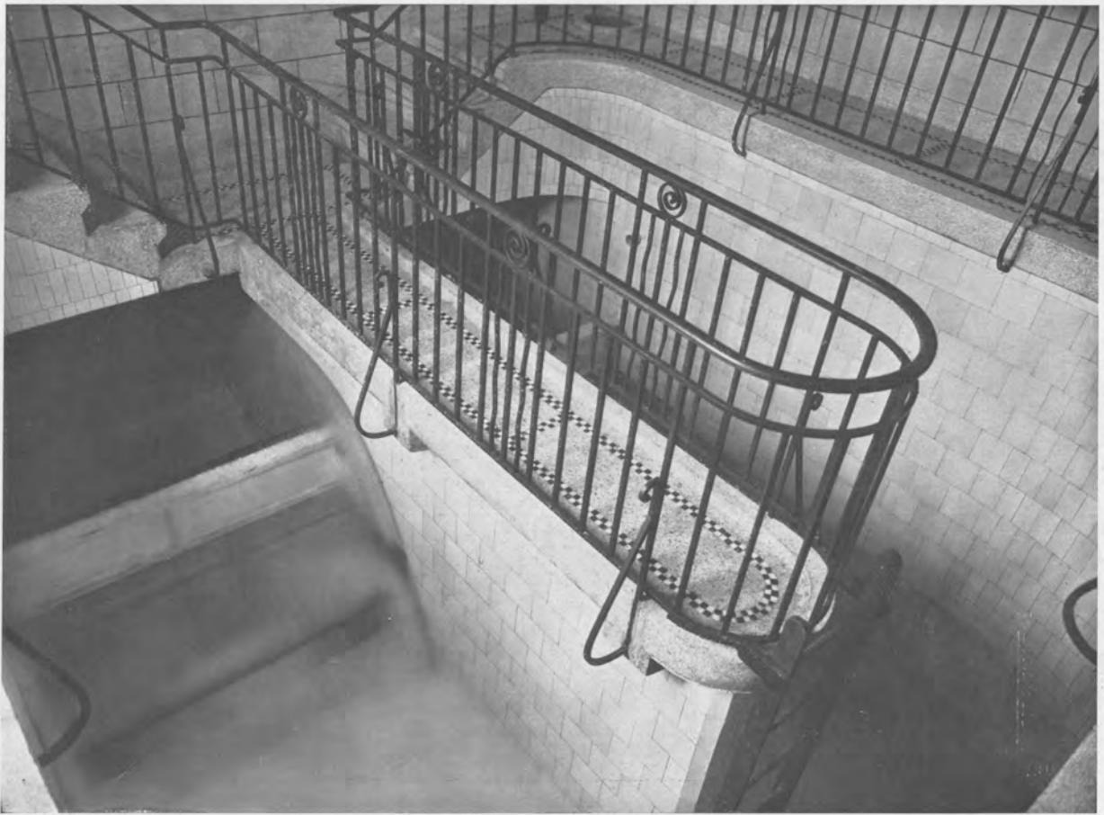
Compagnie Intercommunale des Eaux. Nouveau réservoir à Rhode-Saint-Genèse. Revêtement de faïences blanches. Pavement, marches et limon en granito clair. Exécution : Et. H. Baudoux. Photo : Willy Kessels.
