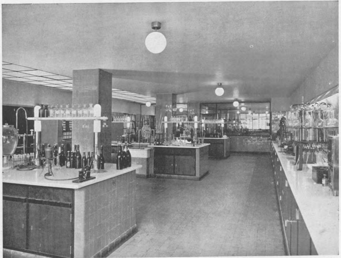
Brasserie Wielemans-Ceuppens. Architecte : M. A. Blomme. Laboratoire et salle de dégustation. Pavement en carreaux céramiques 10 x 10 verts. Revêtement en carreaux 15 x 7.5 de grès jaunes placés verticalement. Exécution : Et. H. Baudoux. Photo : Willy Kessels.
