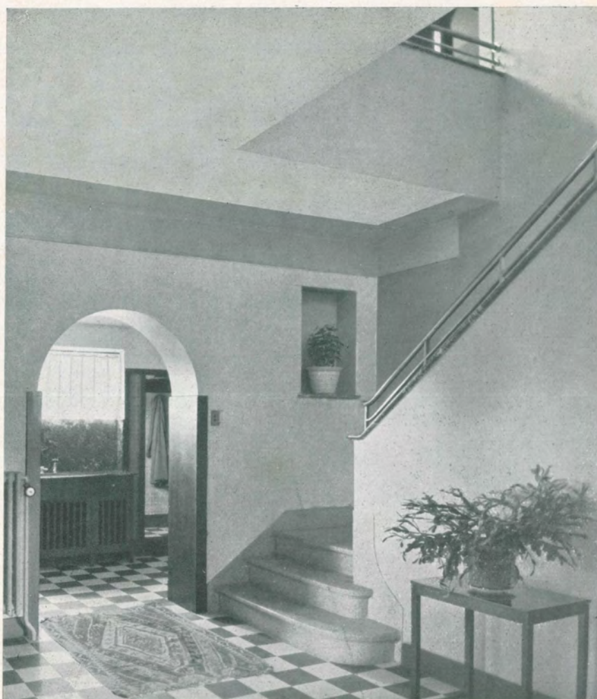
Villa à Heusy-Verviers. Architecte : M. A.-C. Duesberg. Vestibule et vestiaire. Escalier et limons de murs en granito jaune. Exécution : Et. H. Baudoux. Photo : Duquenne.
