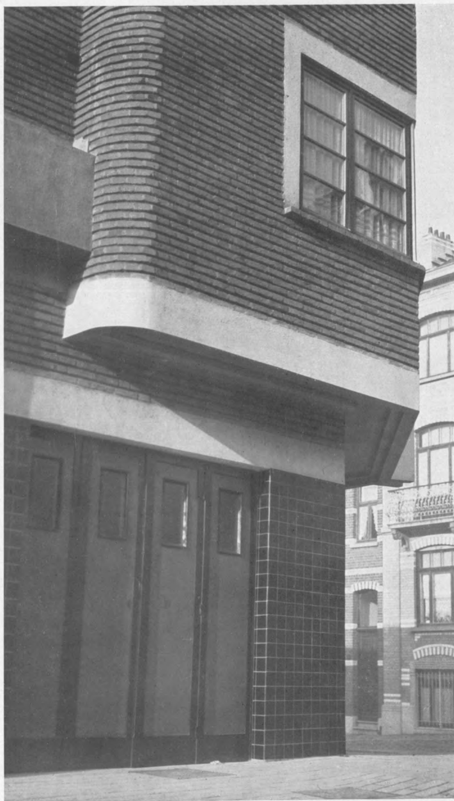
Immeuble à Uccle. Architecte : M. Tenaerts. Soubassement en carreaux de grès majoliques noirs. Exécution : Et. H. Baudoux. Photo : W. Kessels.
