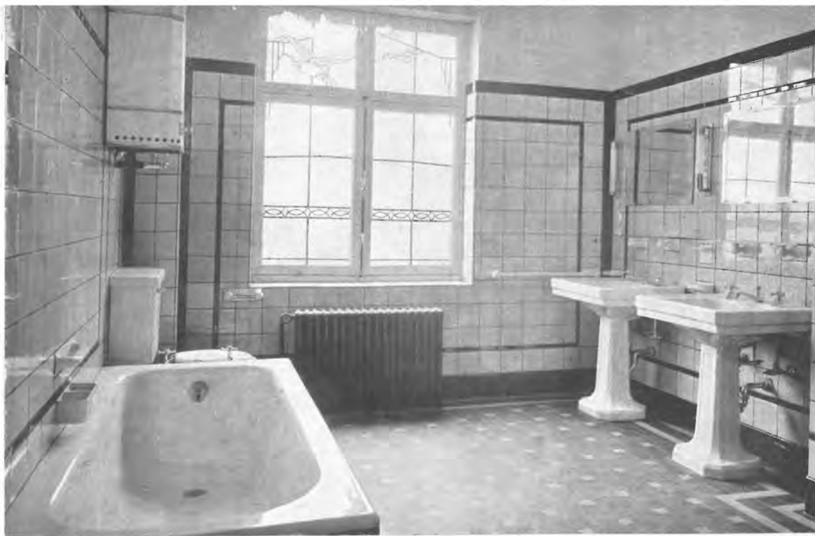
Salle de bain. Architecte : J. Vandervorst. Revêtement en carreaux 15 x 15 chamois placés à larges joints, décoration noire. Pavement en carreaux céramiques 10 x 10 noirs et 5 x 5 jaunes, bordure jaune. Exécution : Ét. H. Baudoux. Photo : W. Kessels.
