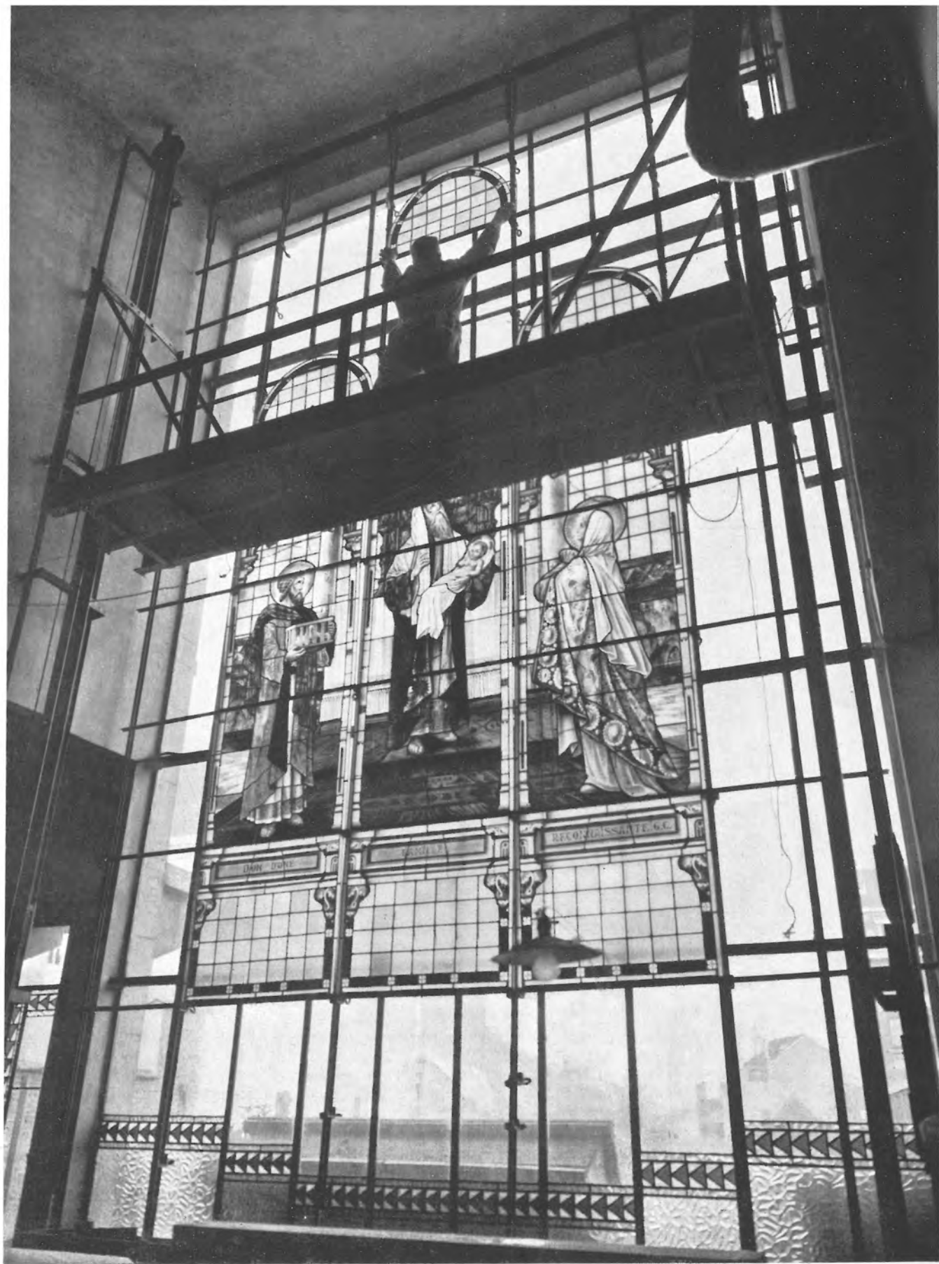
Mise en place d'un vitrail. Exécution : F. Crickx. Photo : Willy Kessels.
