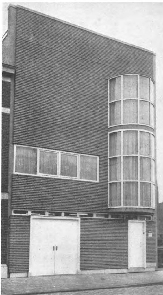
Prix d'architecture Van de Ven 1933. 2 me Mention. - Immeuble à Anvers. Architecte : M. W. Van den Broeck d'Anvers.
