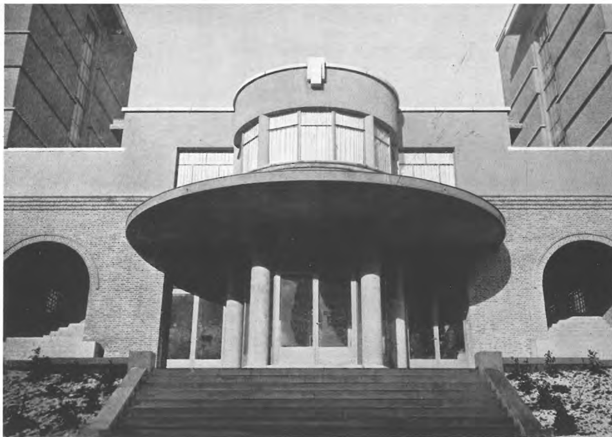
Cité Estudiantine Paul Héger. Architecte : M. Alexis Dumont. Façade. Détail du porche d'entrée. Colonnes et auvent en granito lavé vert foncé (voir photo de détail en couverture). Exécution : Et. H. Baudoux. Photo : Willy Kessels.
