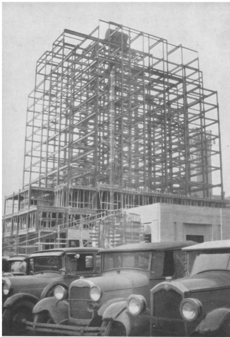
NEW-YORK. — Immeuble à étages multiples en construction. L'ossature métallique.
