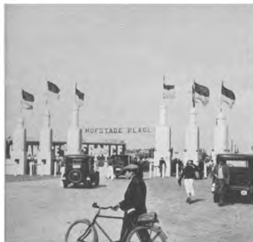
... franchissons une sorte de portique composé de six colonnes...
